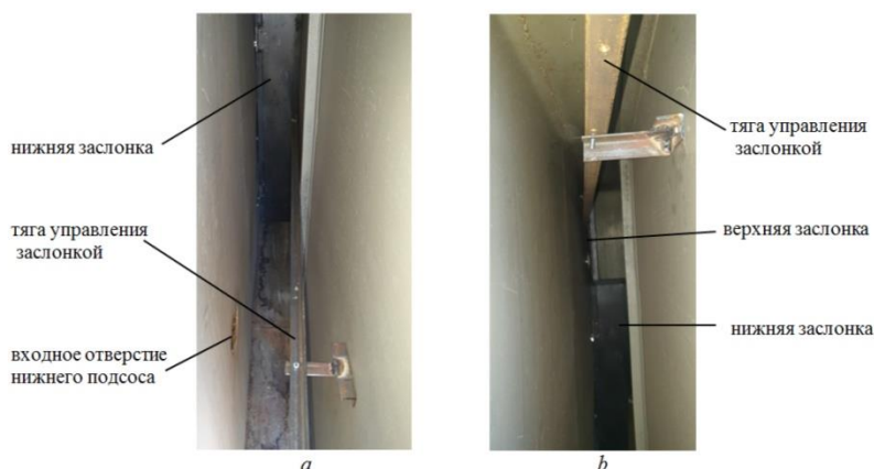
Рисунок 3 - Внутренний контур рециркуляции: а – вид на нижнюю заслонку; б – вид на верхнюю заслонку
